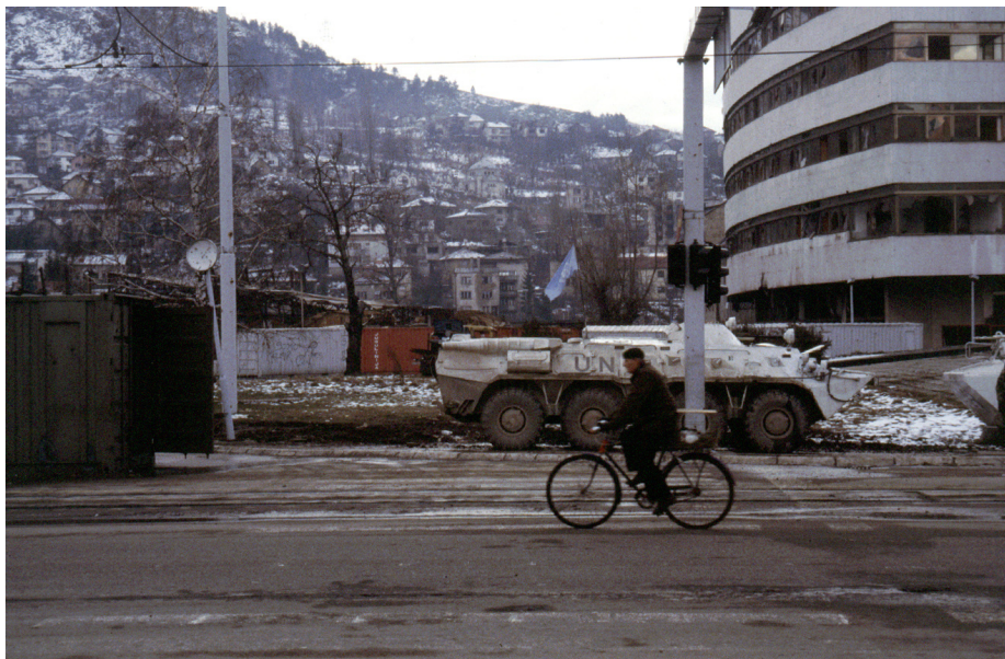
“Procjep smrti”, prostor koji je štitio samo transporter UN-a i gdje su srpski snajperisti redovno gađali pješake i vozila u prolazu. Oštećena zgrada bosanskohercegovačke skupštine je desno. (Autorova fotografija, januar 1995.)
