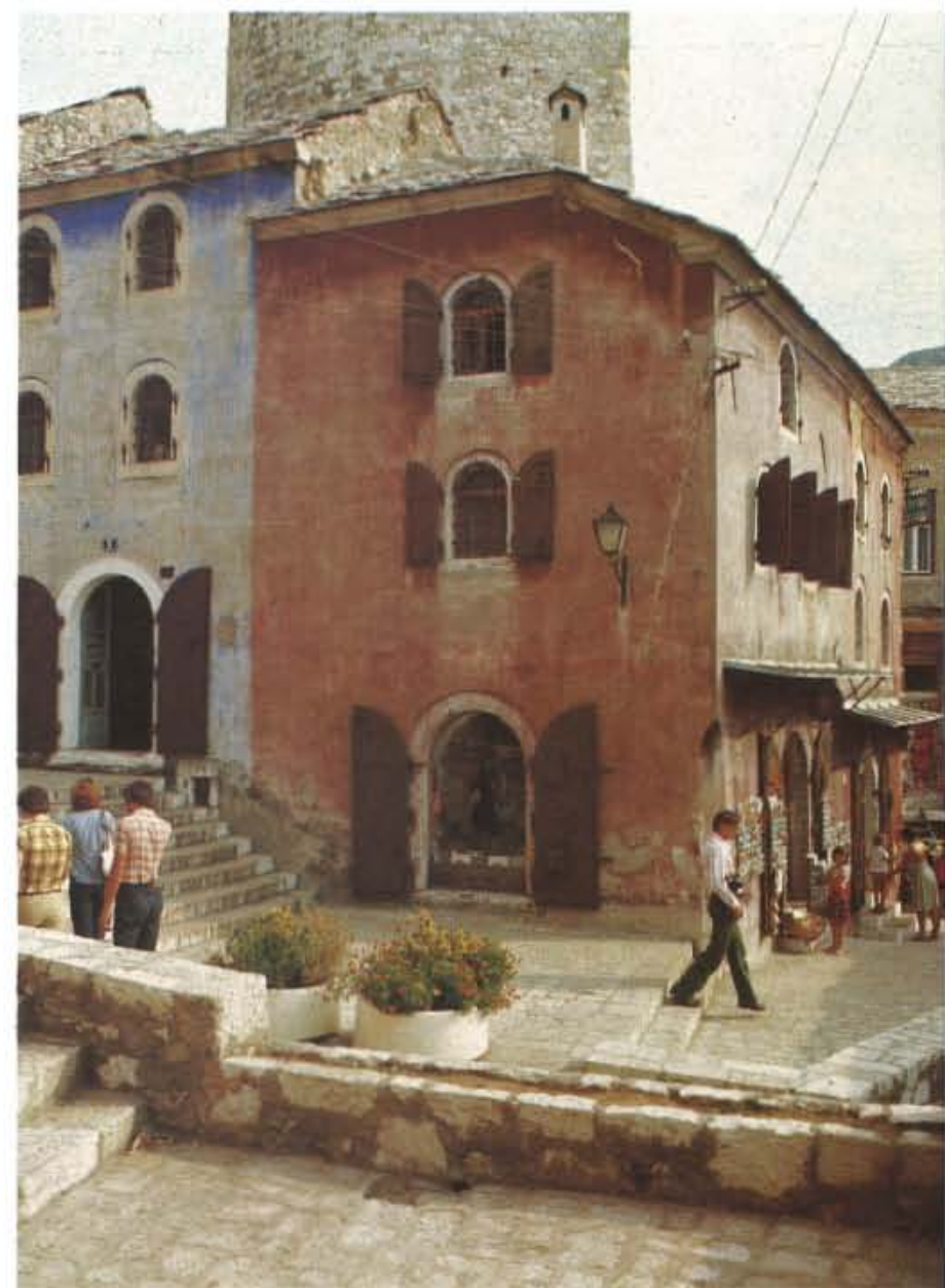
78. Magaze kraj Starog mosta u Mostaru, kraj XVIII, početak XIX st. Kamena gradnja, svodovi, mali polukružno zasvedeni otvori, željezni kapci i demiri... odražavaju strah od provala i požara, ali i utjecaje arhitekture Mediterana.
